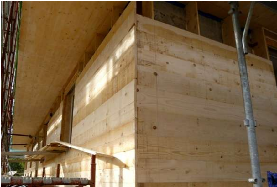
Realizzazione casseri lignei sulle murature
