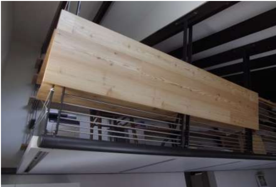
Soppalco interno appeso alle travi rinforzate
