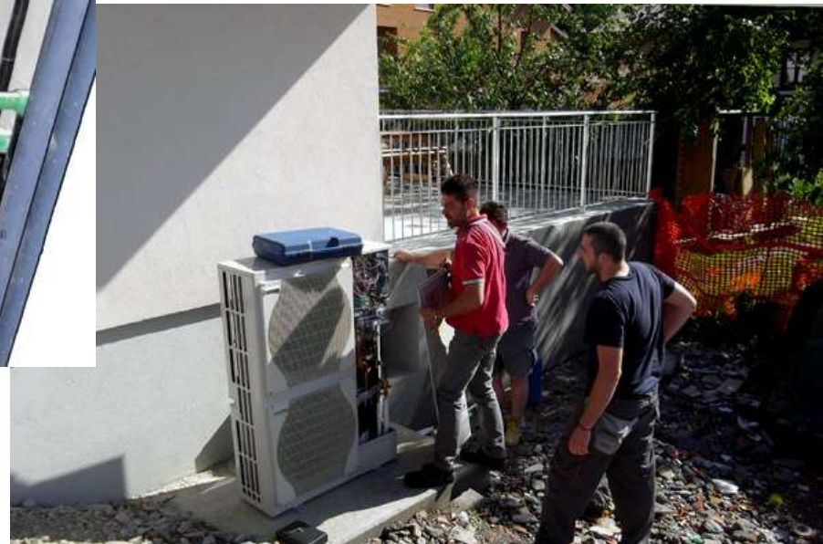
Pompa di calore aria-aria e collettori VMC
