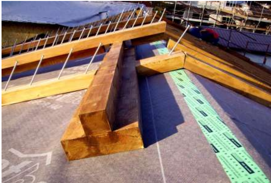
Travi di rinforzo a T a scomparsa reggi sopplaco
