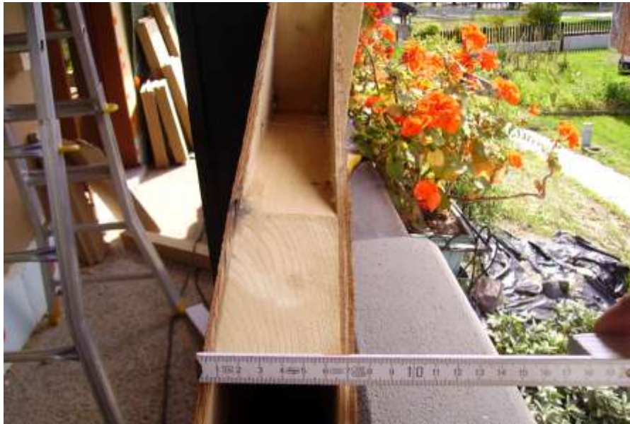
Sistema intelaiato da 75 mm di spessore
