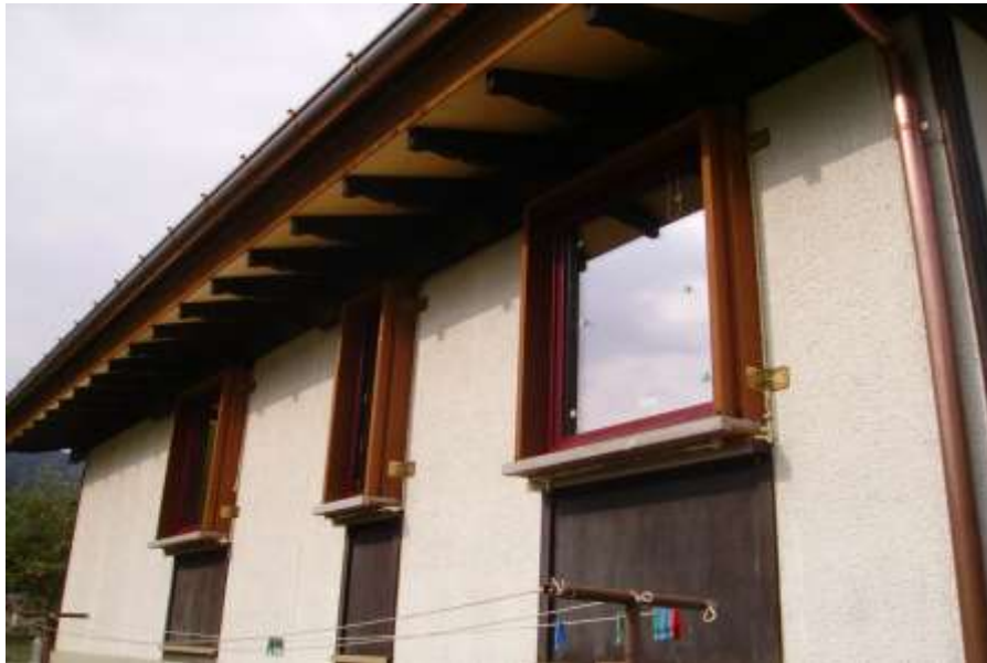
Alloggiamento finestre monoblocco a sbalzo
