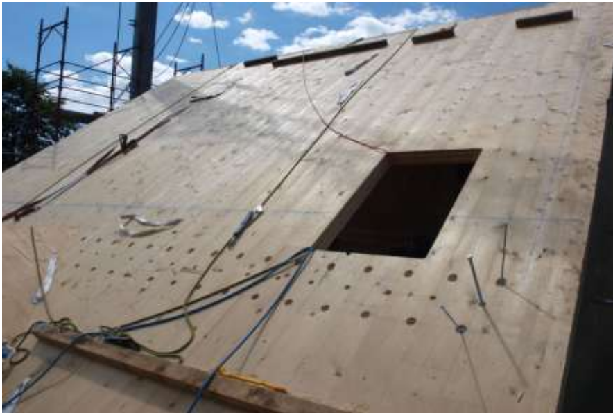
Pannelli di copertura in X-lam con fissaggi
