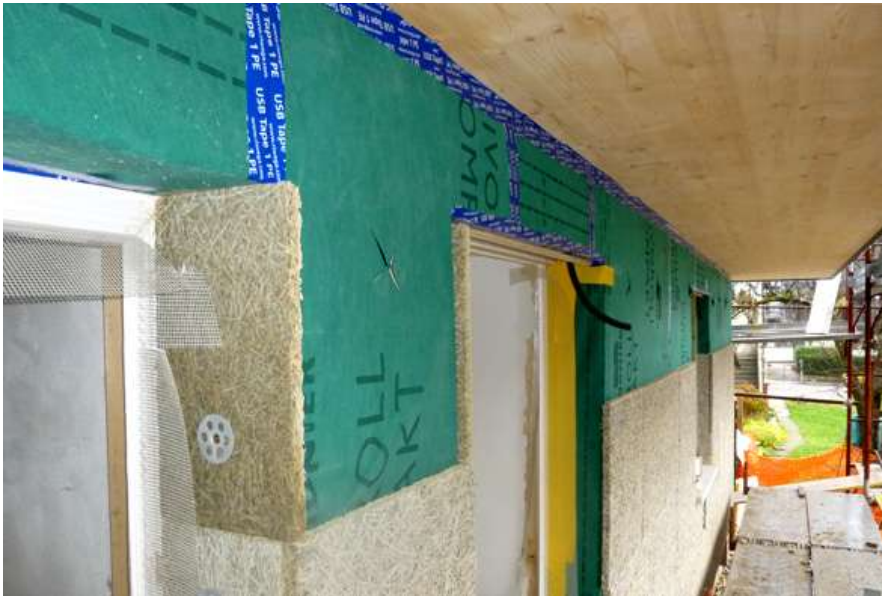
Applicazione pannelli porta intonaco su telo
