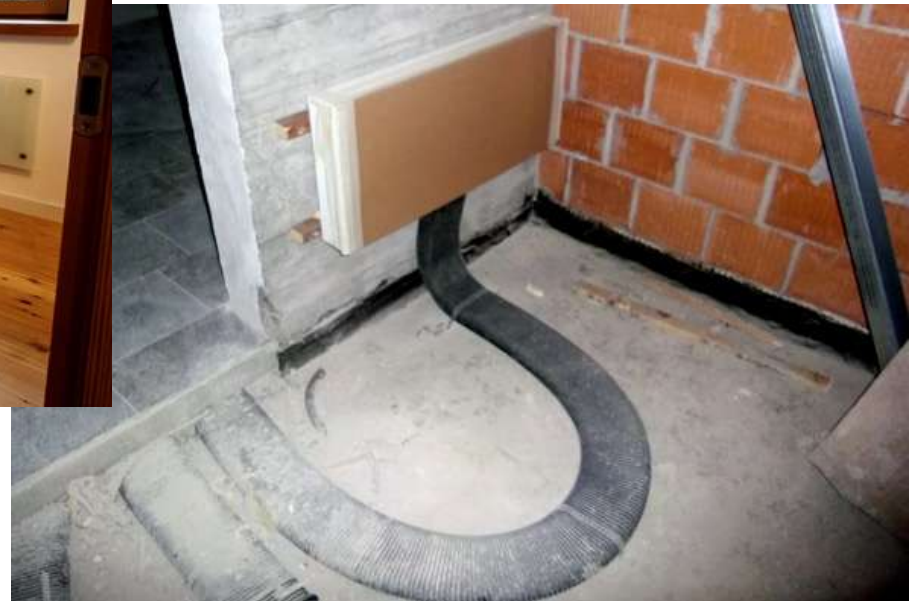
Distributori VMC con riscaldatori integrati
