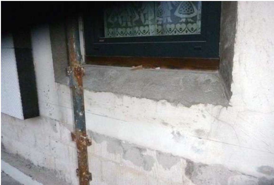
Taglio inclinato spallette per risvolto cappotto
