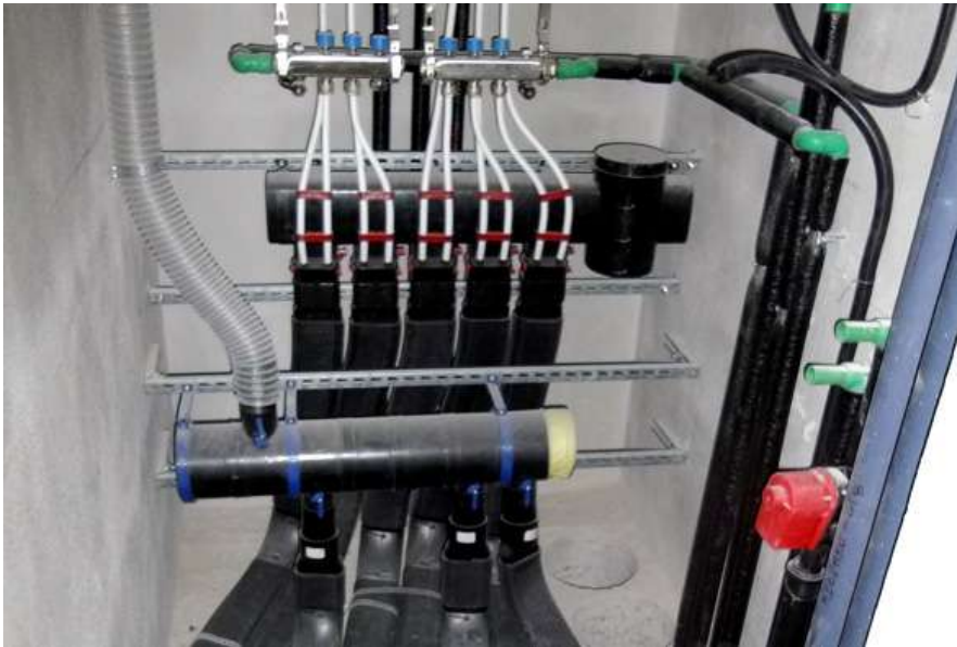
Pompa di calore aria-aria e collettori VMC
