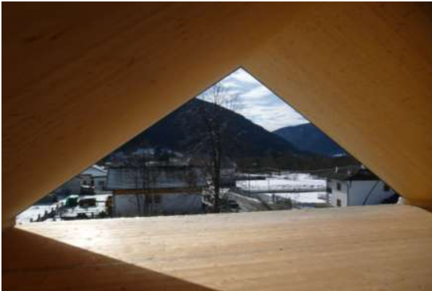
Copertura X-lam a vista con isolamento esterno
