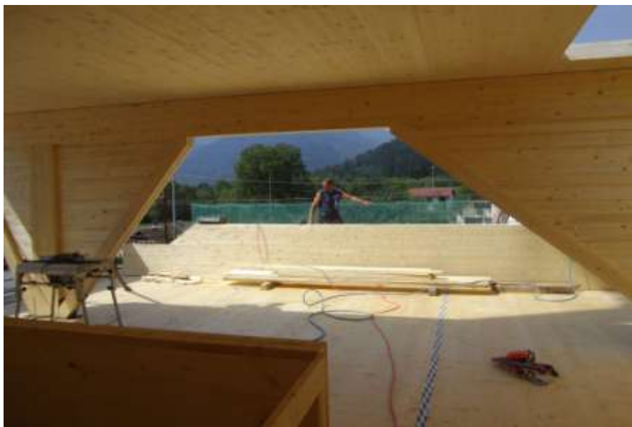
Coppia telai in L.L. reggi solaio mansarda
